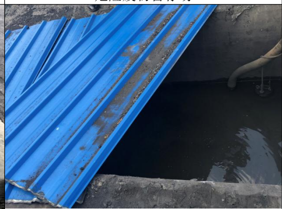
危险废物暂存场初期雨水收集池
