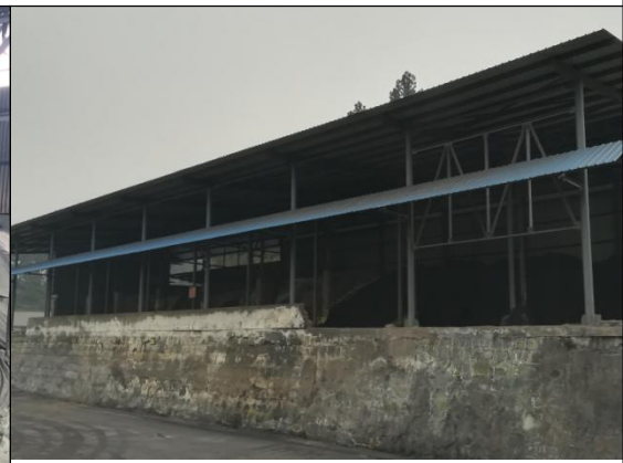
危险废物暂存场
