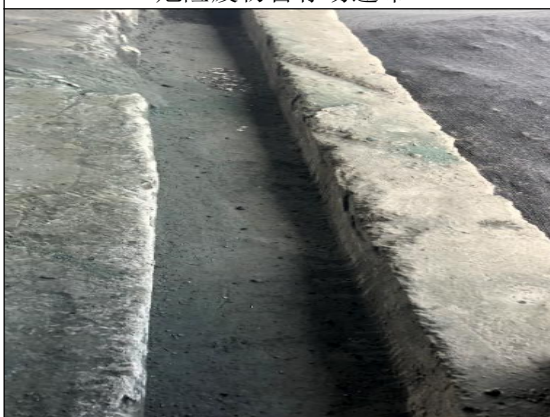
危险废物暂存场导流沟
